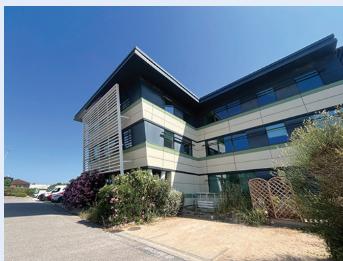
Immeuble de bureaux à Aix-en-Provence (13)
