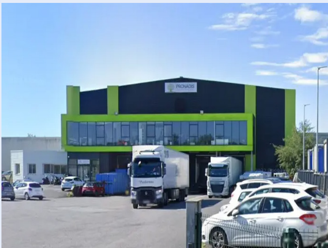
Entrepôt d'activité à Vayres (33)
