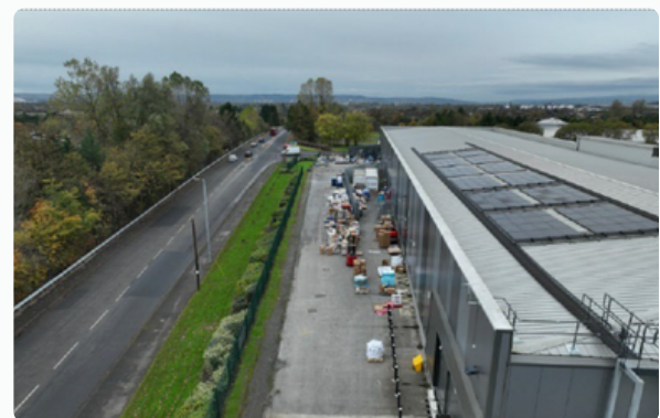
Panneaux photovoltaïques sur l'actif situé à Glasgow.
