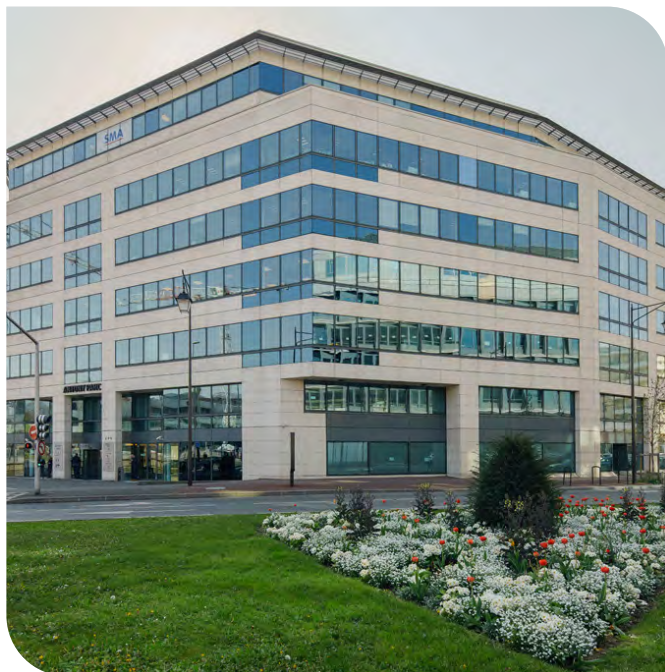
Portefeuille PERIAL O 2 : Immeuble « Antony Parc »
